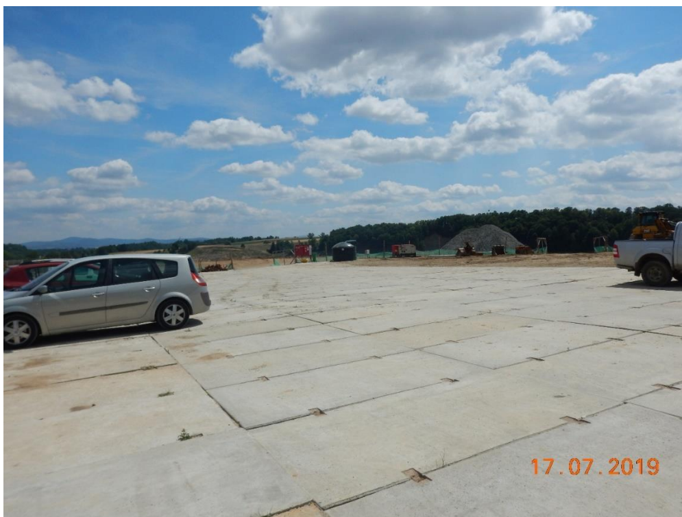
Fot. 1. Zaplecze budowy – teren zaplecza został uszczelniony od podłoża (poz. 85 PZŚ).
