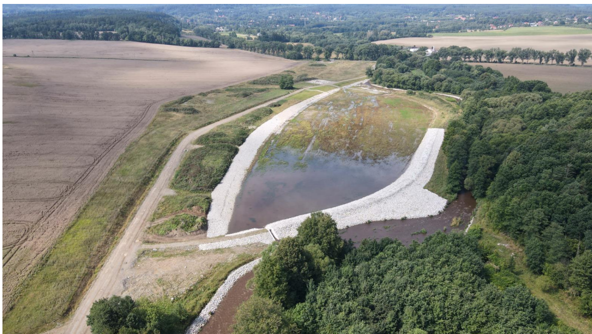
Fot. 17. Wykonany łapacz rumoszu na terenie zbiornika.
