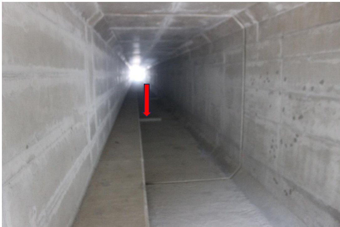
Fot. 12. Wykonane progi w dnie kanału spustowego – czerwona strzałka (poz. 56 PZŚ).
