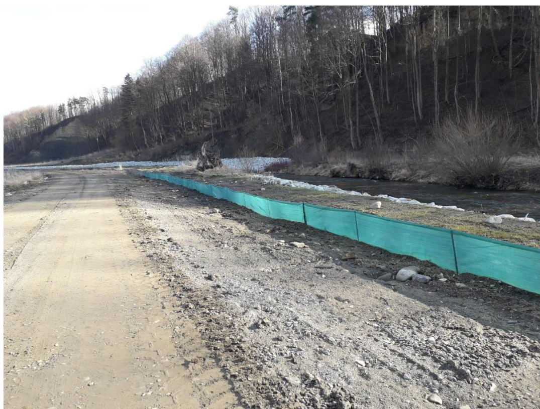
Fot. 13. Wykonane zabezpieczenia przed wkraczaniem płazów na teren robót (poz. 33 PZŚ).
