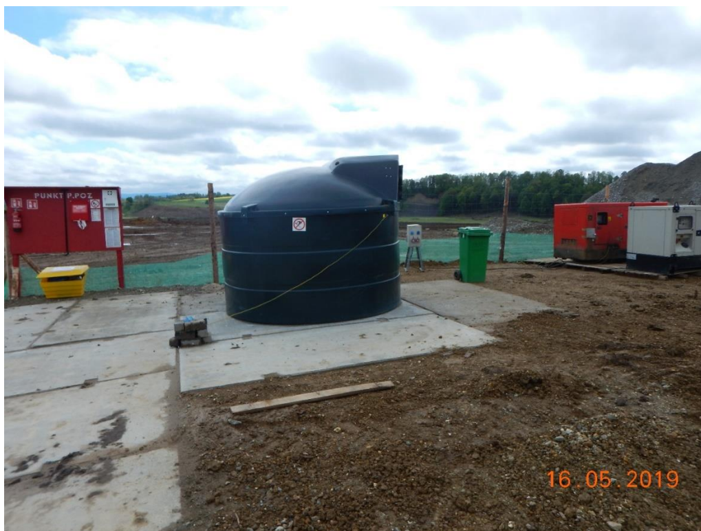
Fot. 2. Miejsce do tankowania pojazdów i maszyn pracujących na budowie zabezpieczone przed przedostawaniem się substancji ropopochodnych do podłoża (poz. 85 PZŚ).
